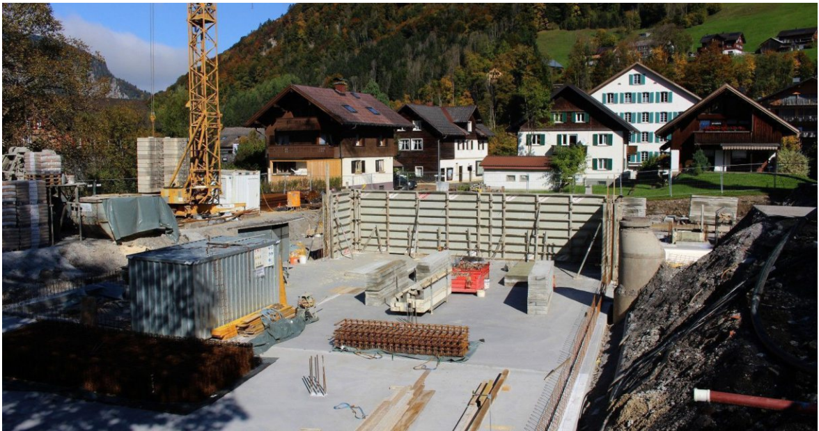
Im Oktober wurden die Baumeisterarbeiten gestartet.
