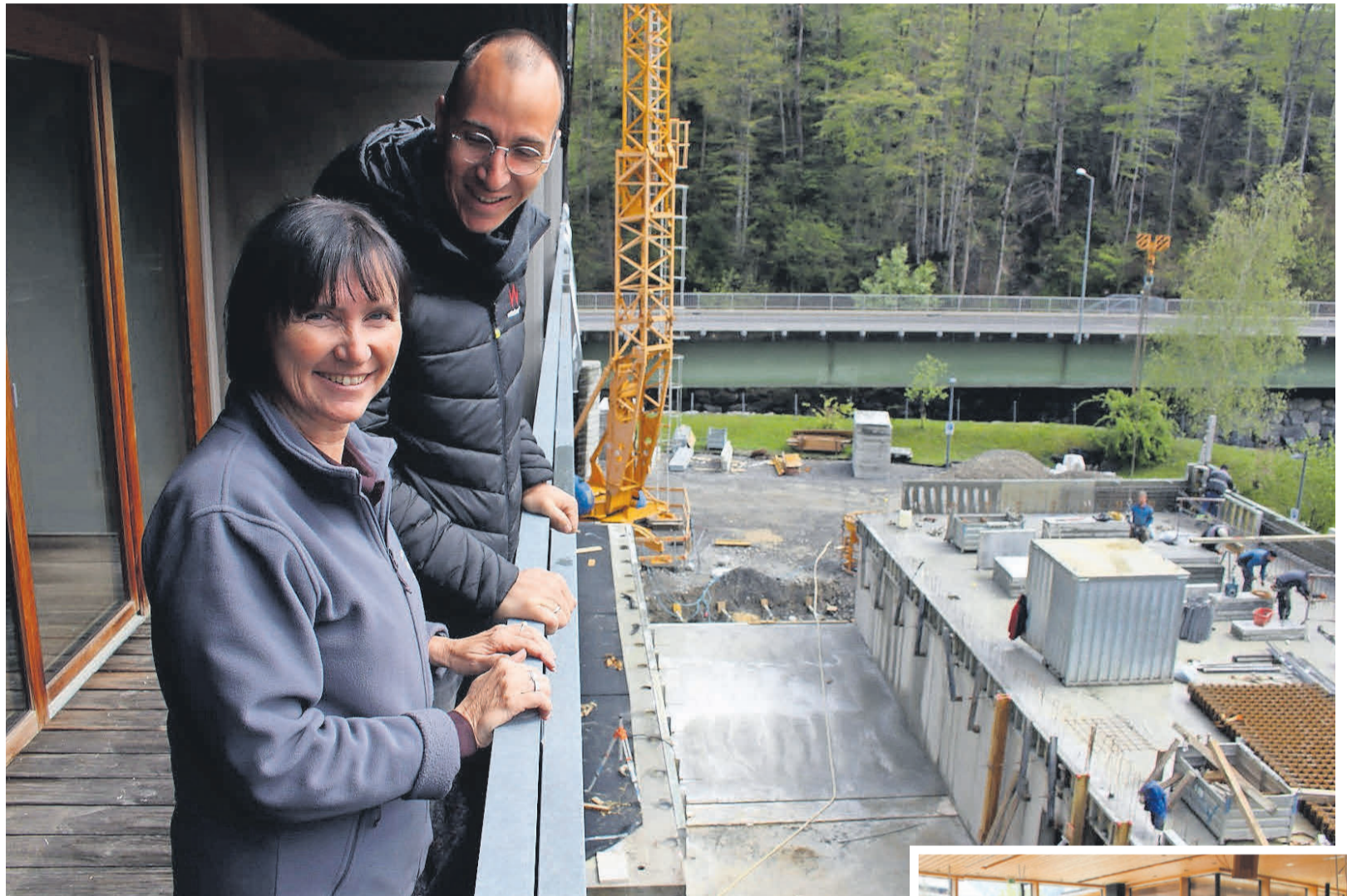
Natalie Lässer und Architekt Federico Rovetta zeigen die Fortschritte bei den Bauaktivitäten.
