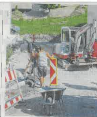
Die Sanierung des Güterwegs Oberkirchberg endet noch im Oktober. VN/JS
