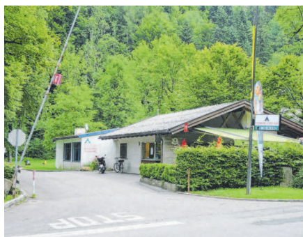
Der Campingplatz Enz soll um über drei Millionen Euro zu einem international vorzeigbaren 4-Sterne-Platz ausgebaut werden. FOTO: HAGEN
